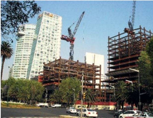
FIGURA 3. Construcción de edificios Paseo de la Reforma
