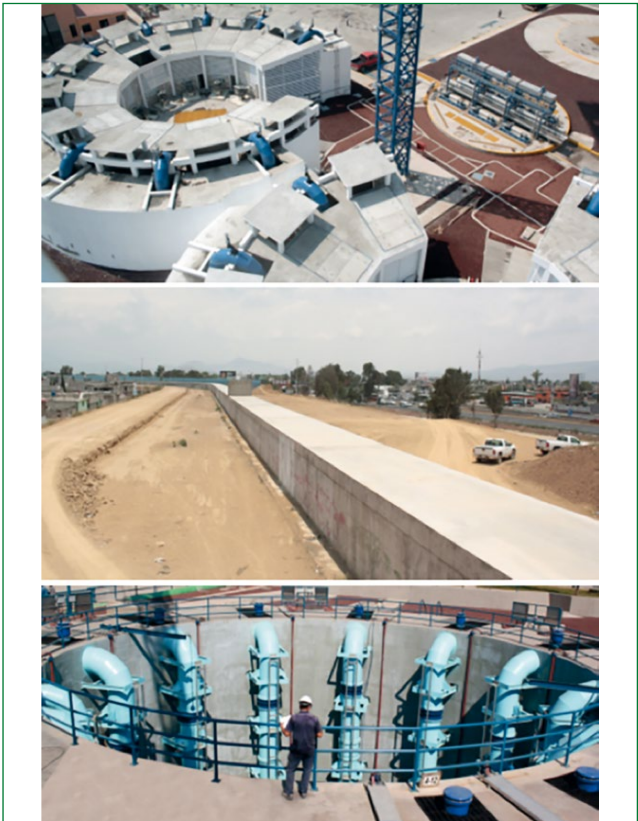
FIGURA 1.25. Obras realizadas para el control de inundaciones en la RHA XIII Aguas del Valle de México
